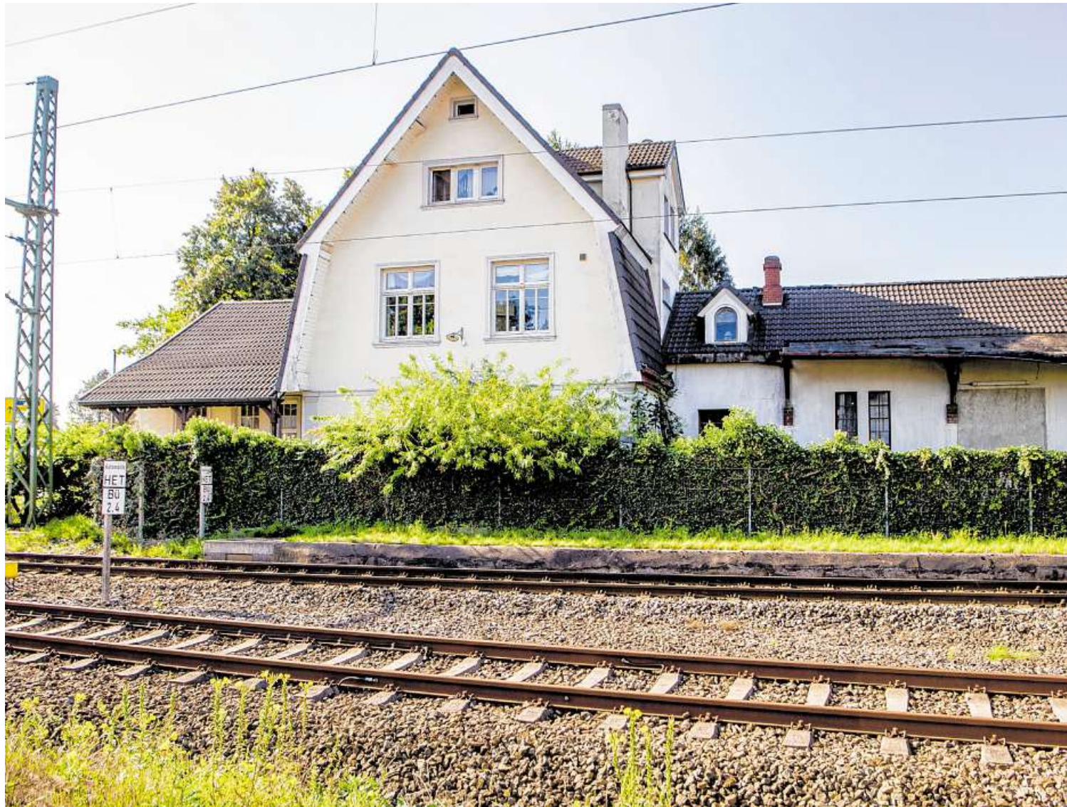
Weil sich Aldi an der Hammersbecker Straße vergrößern will, soll das frühere Empfangsgebäude der Bahn auf dem Nachbargrundstück abgerissen werden. FOTO: MAXIMILIAN VON LACHNER
